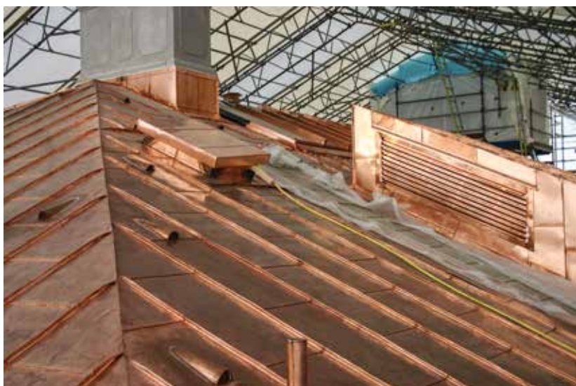
Kobberarbejde på Carlsbergfondets bygning på H.C. Andersens Boulevard.
